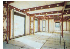
頑強で、しかも可変性に富む構造壁の少ない躯体内部
